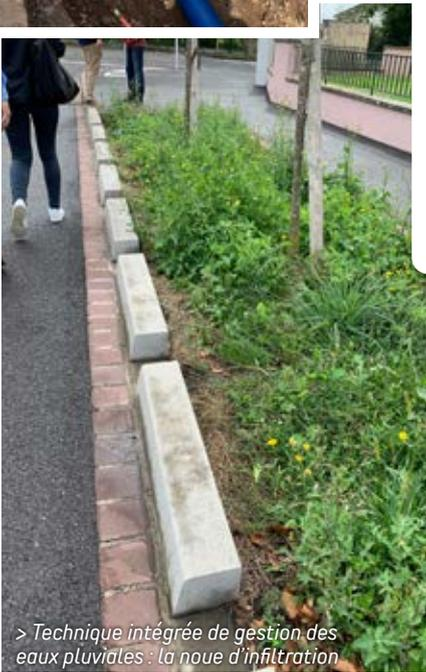
> Technique intégrée de gestion des eaux pluviales : la noue d'infiltration
