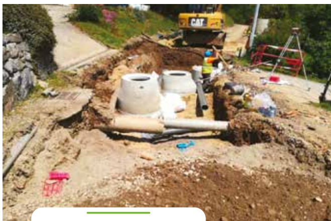
Travaux Rue des Maquisards à Willer-Sur-Thur
