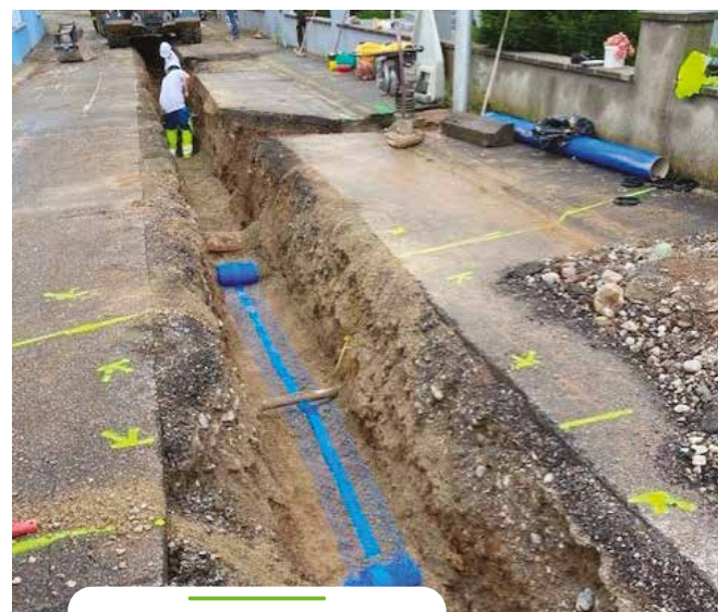
Travaux Rue des Vignes à Cernay
