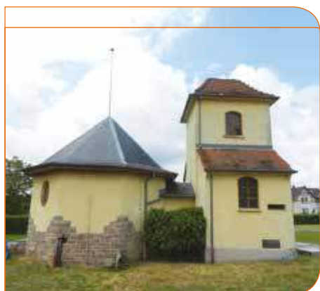
Captages des eaux Rue des Puits à Cernay gérés en régie
