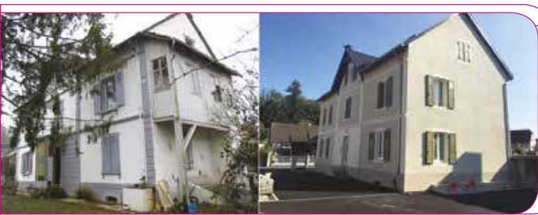
Colorisation de façades avant et après travaux
