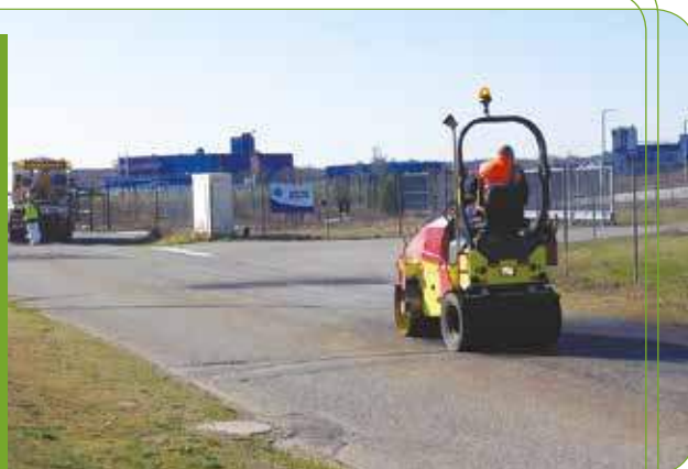
Réfection de la rue de l'Industrie à Cernay (ZI Est)
