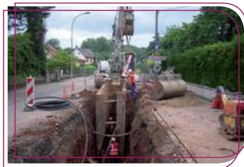
Dans le cadre de l'opération de la Cote 425, la CCTC mène, avec le Conseil Général, des travaux pour permettre le traitement des eaux de ruissellement rue du Moulin à Steinbach : l'enrochement actuel en contrebas des vignes sera prolongé, un collecteur d'eaux pluviales créé, les réseaux de la rue seront réaménagés et un fossé permettra le rejet des eaux en milieu naturel après la traversée de la départementale 35.
